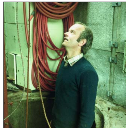
Udo Vierhaus bei der Inspektion der Pumpe
