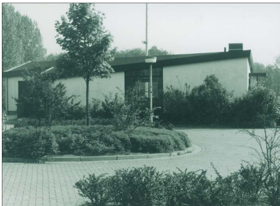
Der Anbau nach seiner Fertigstellung
