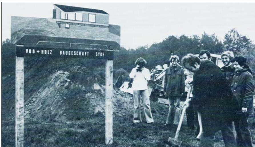
18. Oktober 1976: Der erste Spatenstich
