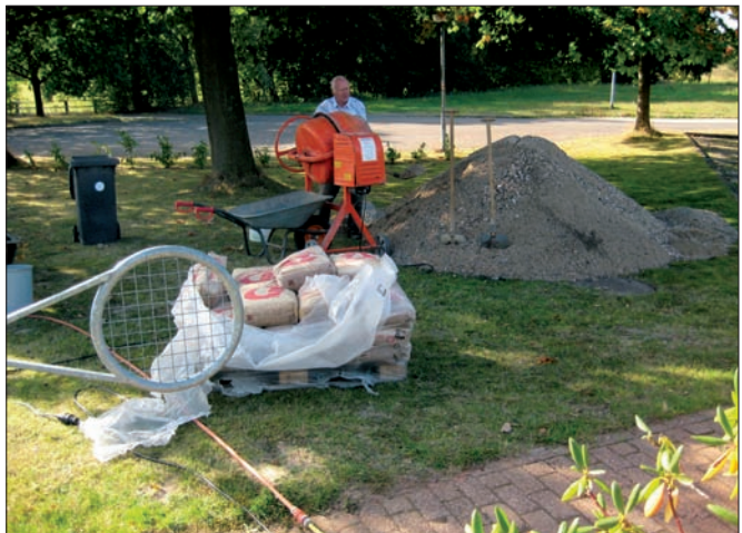
Manfred mischt Beton für das Fundament an...
